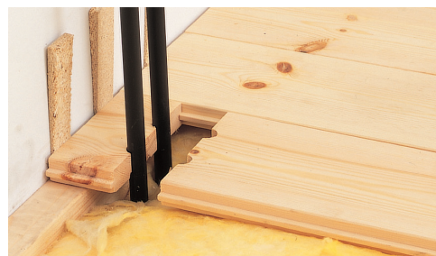
4. Gør hullet 10 mm større end rørets diameter
