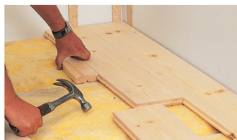
2. Anvend en slagklods som beskyttelse når du slår brædderne sammen
